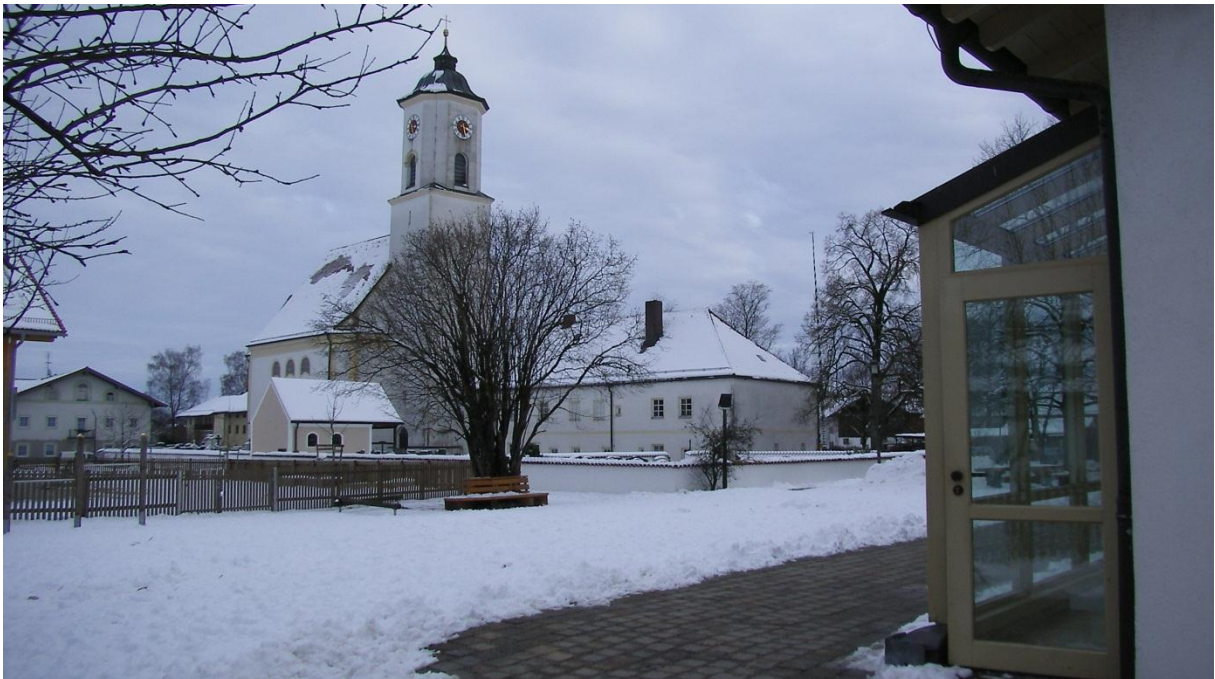
Abbildung 61: Kirche mit Pfarrhaus und Mischbebauung (Schulweg, Hohenlinder Straße)
